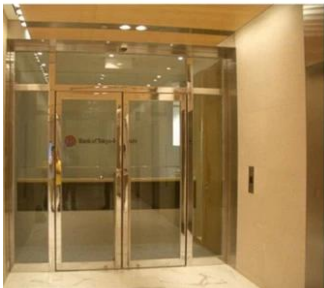
Vidro isolante resistente ao fogo usado para divisória de edifícios
