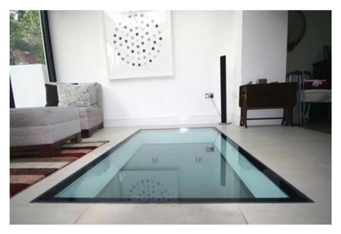
15 + 15 + 15mm schwarzer Siebdruck gehärtet laminierend Glas Fußboden Spezifikationen::
